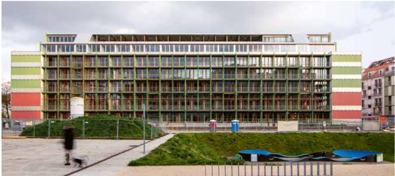
Die Balkonschicht wirkt als Mittelgrund zwischen Wohnen und der werdenden Stadt. Auf der Brache entstehen bald neue Wohnungen.
