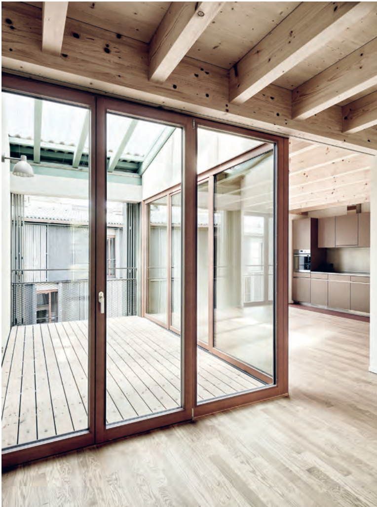
Die Träger bilden mal Tür-, mal Fenstersturz und gewinnen dazwischen wertvolle Raumhöhe.
