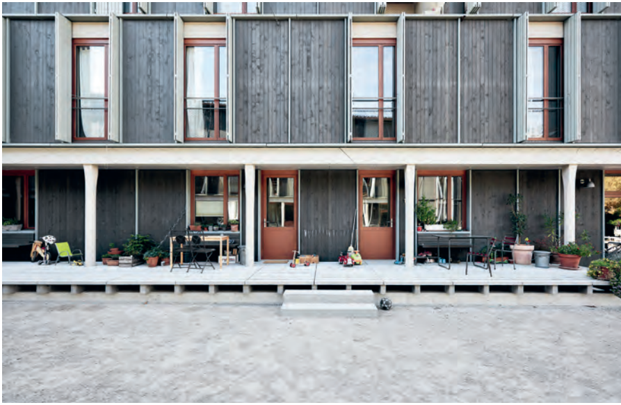
Die Verandastützen der Wohnüberbauung Maiengasse in Basel schrauben sich vom Quadrat zum 32-Eck.
