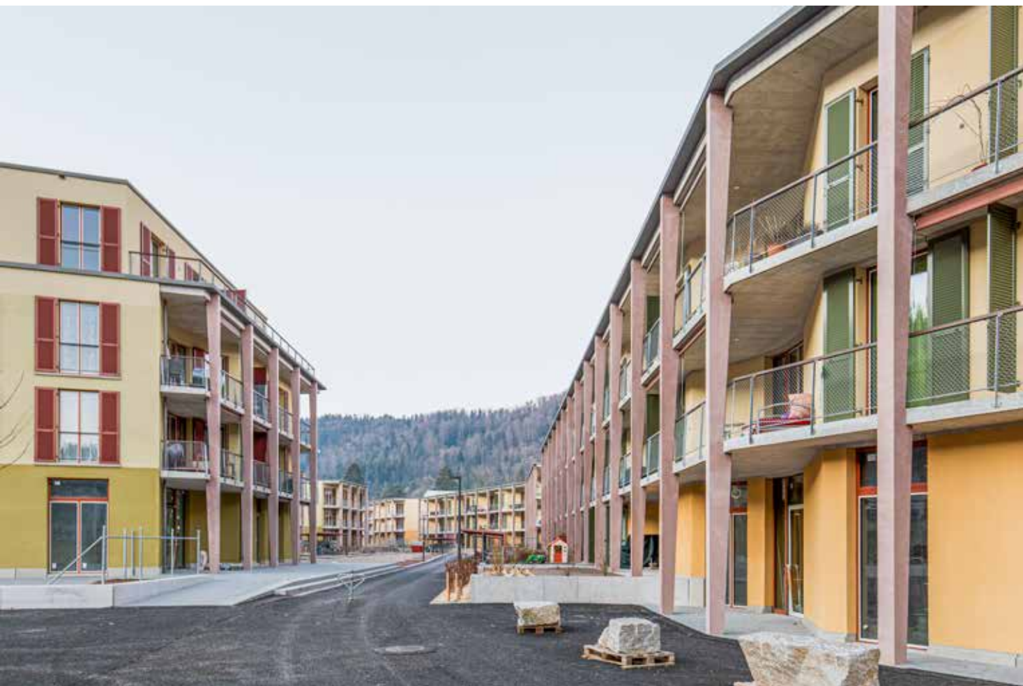
Die Neubauten in Winterthur Sennhof (Heimstätten-Genossenschaft Winterthur) besitzen einen traditionellen Kratzputz, der in Gelb-Grün-Schattierungen eingefärbt ist. Die Farbgestaltung soll den städtischen Auftritt der neuen Grosssiedlung am Stadtrand betonen und dabei auch eine gewisse Festlichkeit ausstrahlen.
