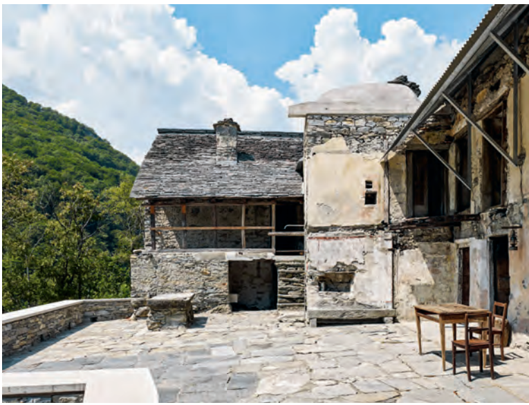
Casa Mosogno: ein Ensemble, zwei neue Dächer, drei Materialien und jede Menge Platz.
