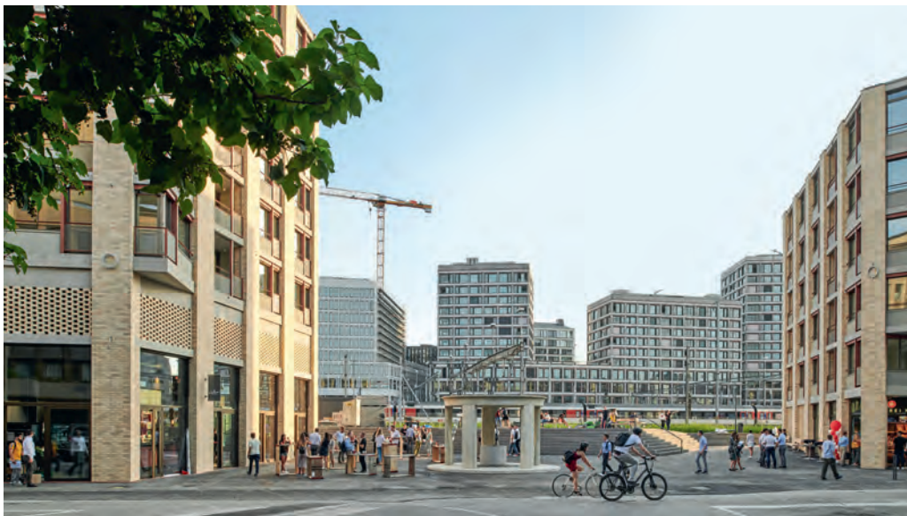
Gegenüber der Europaallee säumt die Zollstrasse das Zürcher Gleismeer. Foto: Martina Meier
