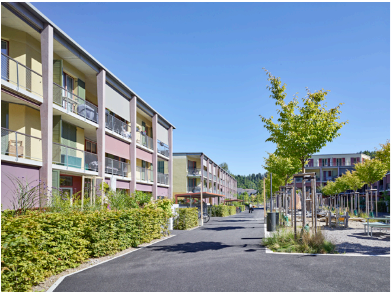
Wohnüberbauung Oberzelg (Esch Sintzel Architekten, Zürich; HGW Heimstätten-Genossenschaft Winterthur)
