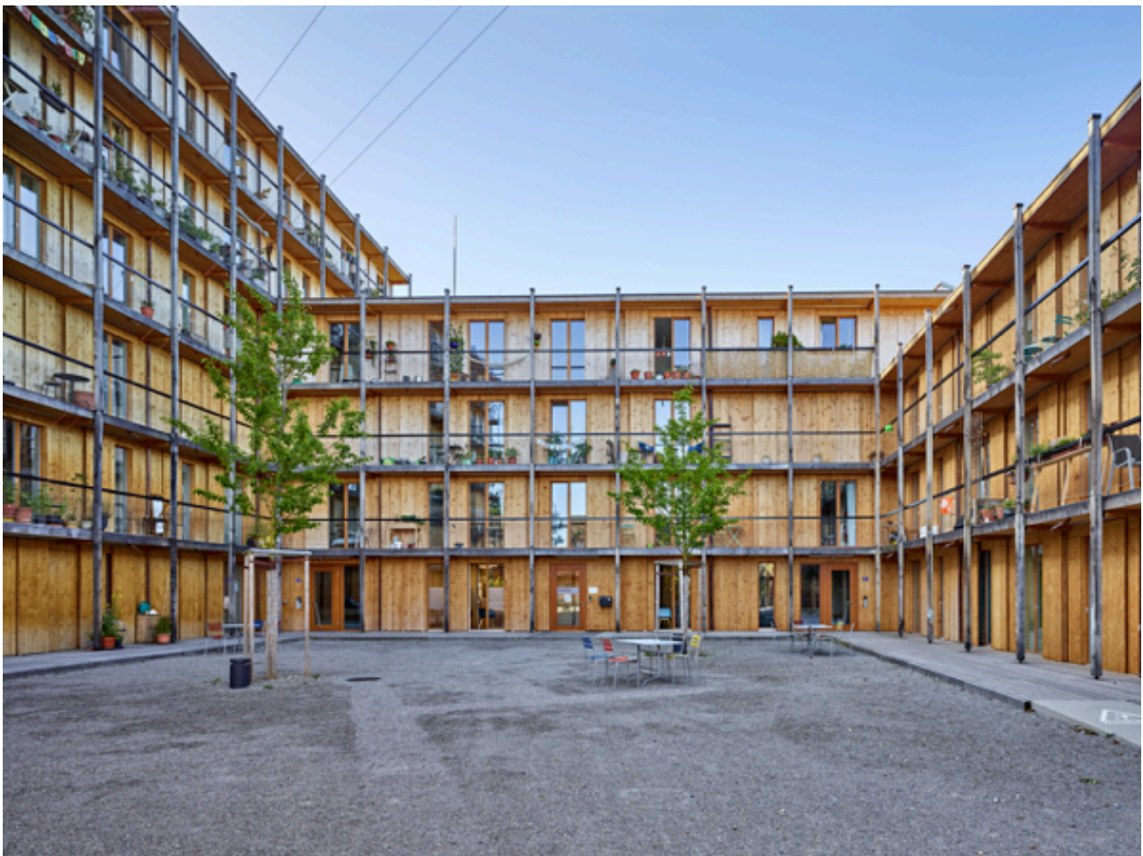
Wohnüberbauung Hagmannareal (weberbrunner Architekten, Zürich; soppelsa Architekten, Zürich; Fritz Hagmann, Winterthur)
