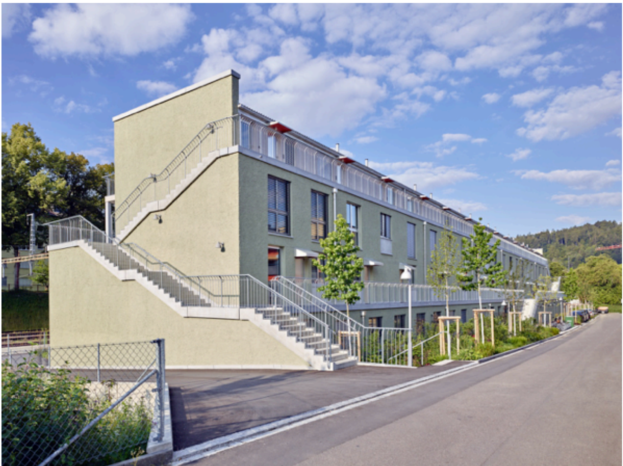
Wohnhaus Bahnhof Töss (KilgaPopp Architekten, Winterthur; LUPK Luzerner Pensionskasse, Halter Gesamtleistungen AG, Zürich)
