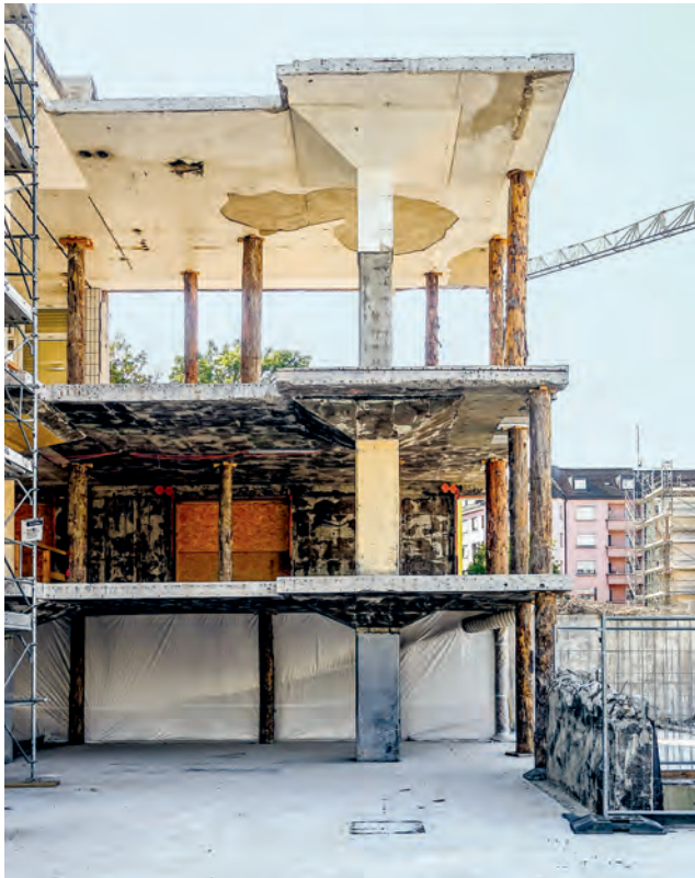
Die Geschosse wurden durch Holzstützen temporär abgestützt.
