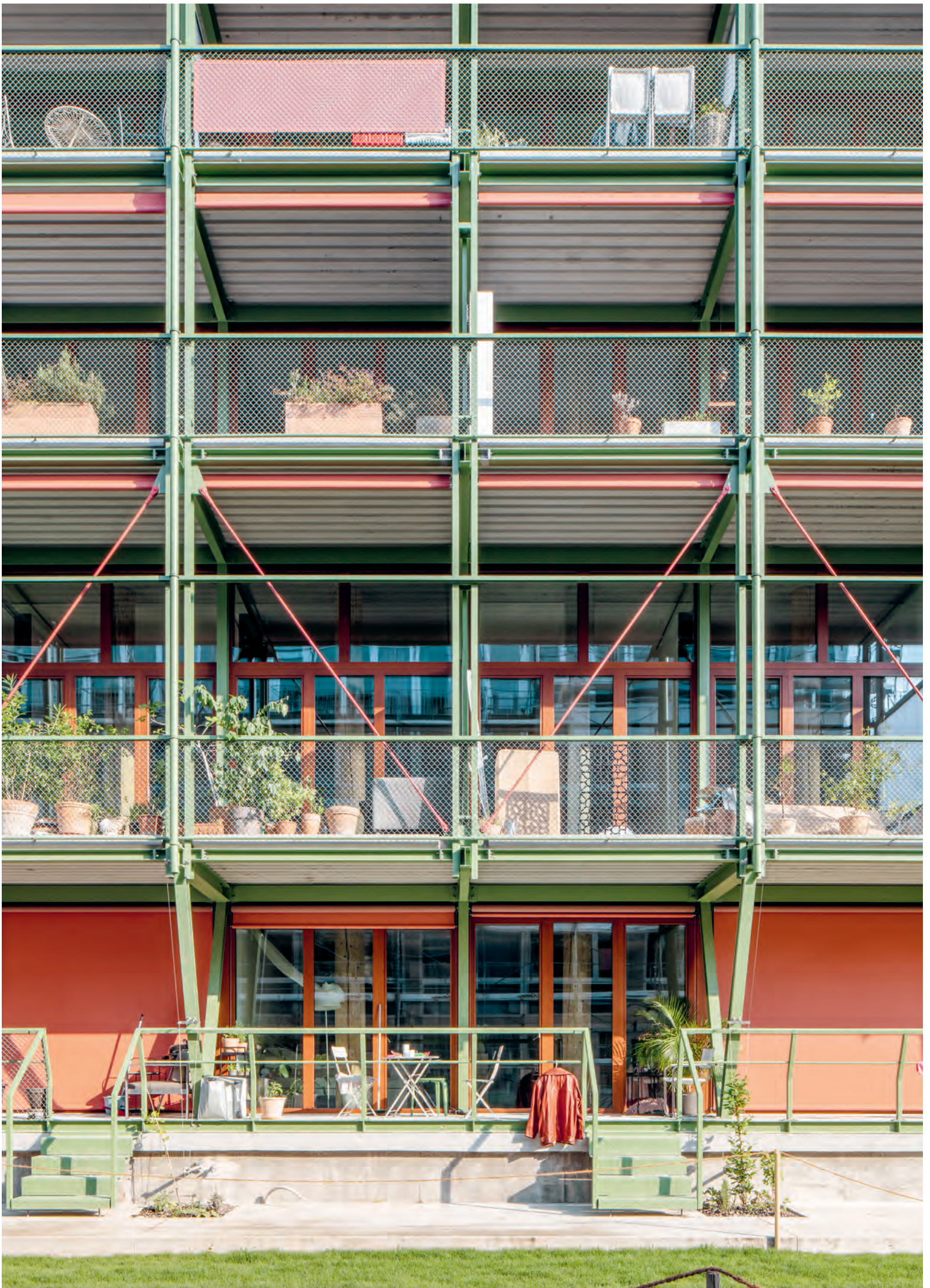
Die neuen Fassaden erinnern an die industrielle Vergangenheit des Weinlagers.
