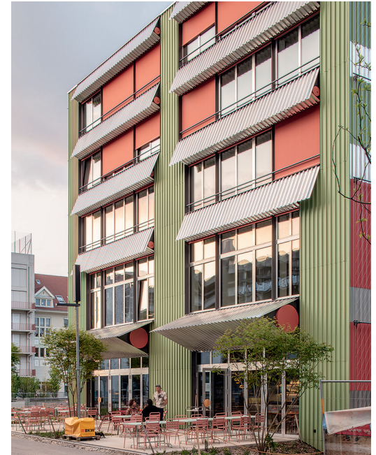
Die Fassaden der Schmalseiten übernehmen die Aluminiumverkleidung des alten Weinlagers konzeptuell, schneiden, falten und klappen sie dabei auf.
